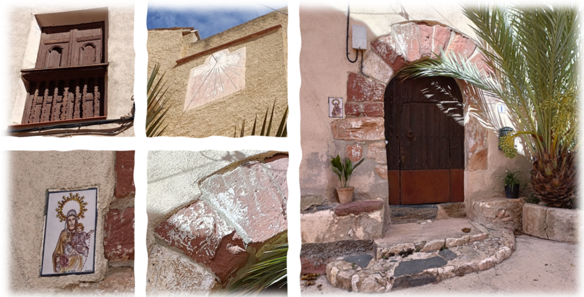
Cal Bargalló: balcó de fusta i rellotge de sol (superior) / Ceràmica de la Verge del Roser i detall de la dovella amb escut esquerre gravat (inferior) / Vista de la porta adovellada i l'esgraó amb empedrat de còdols (dreta).
