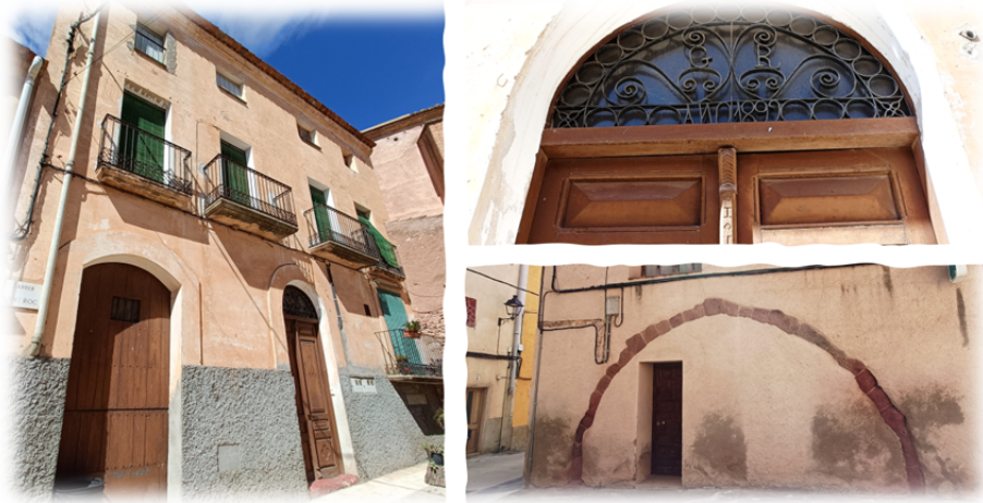
Cal Claro: Detall de la coronació de ferro forjat de la porta amb les inicials i l'any (superior). / Arcada apuntada corresponent a l'antic “matadero” (inferior).
